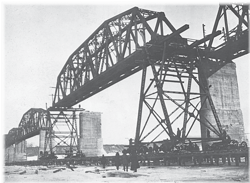
Наводка фермы железнодорожного моста через р. Томь. Кемерово, 1933 г. ГАК. Ф. Фотофонд. Оп. 8. Д. 492. Л. 1
